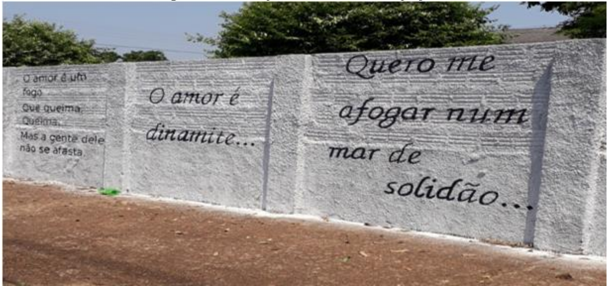
Figura 7. Muro depois das atividades do projeto
